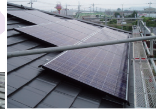
モジュール設置 南
