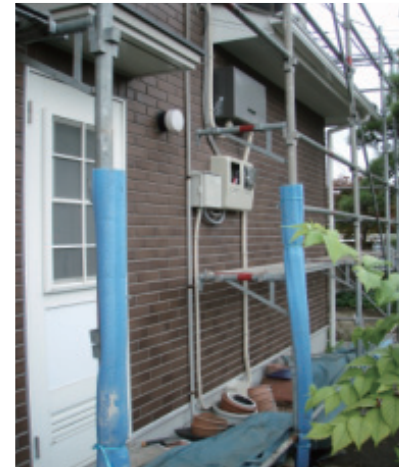
パワーコンディショナ設置
