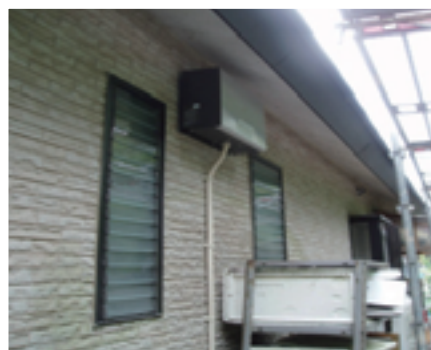
パワーコンディショナー設置
