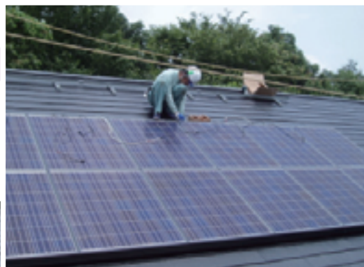
モジュール設置
