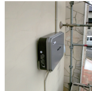
パワーコンディショナ設置
