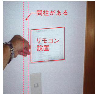
リモコン位置確認 スイッチの左には間柱あり
